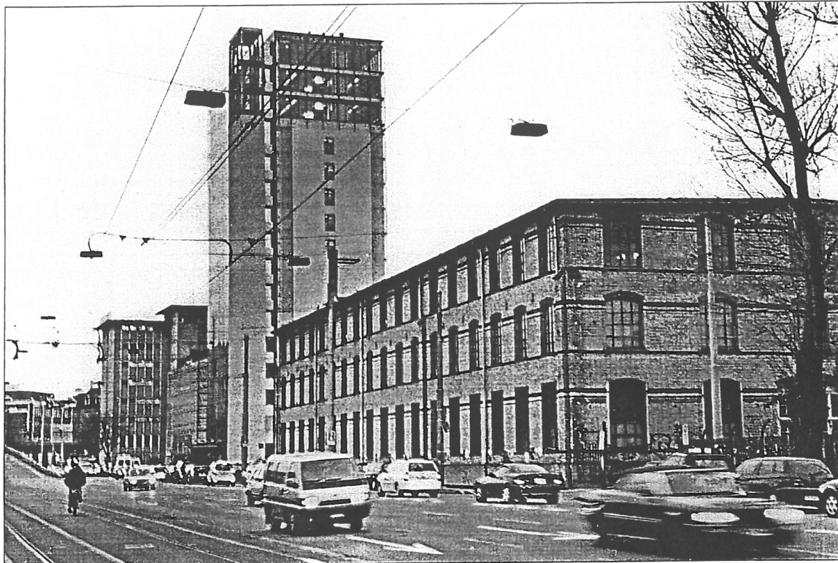
SCHAUPLATZ FÜRS FLICK-PRIVAT-MUSEUM: Ehemaliges Modellmagazin der Sulzer-Escher Wyss AG in Zürich West FOTO: GERTRUD VOGLER
